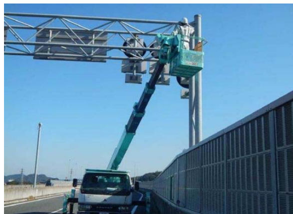
<リフト車による点検状況>
