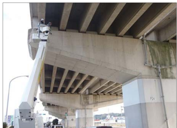
<リフト車による定期点検状況>
