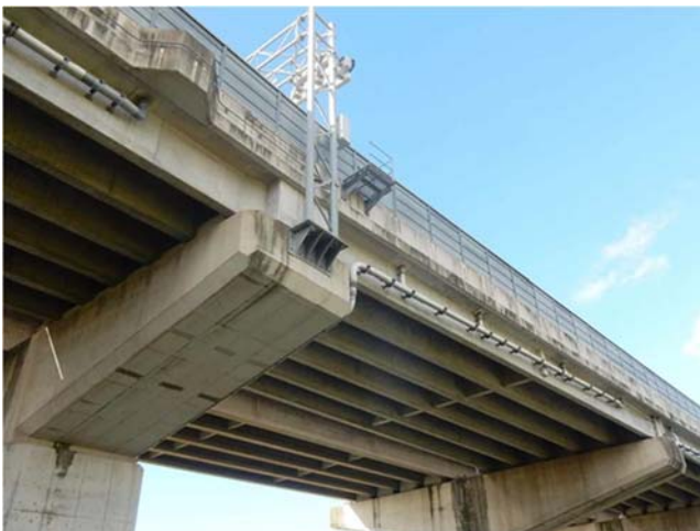
前原高架橋下り (5)
