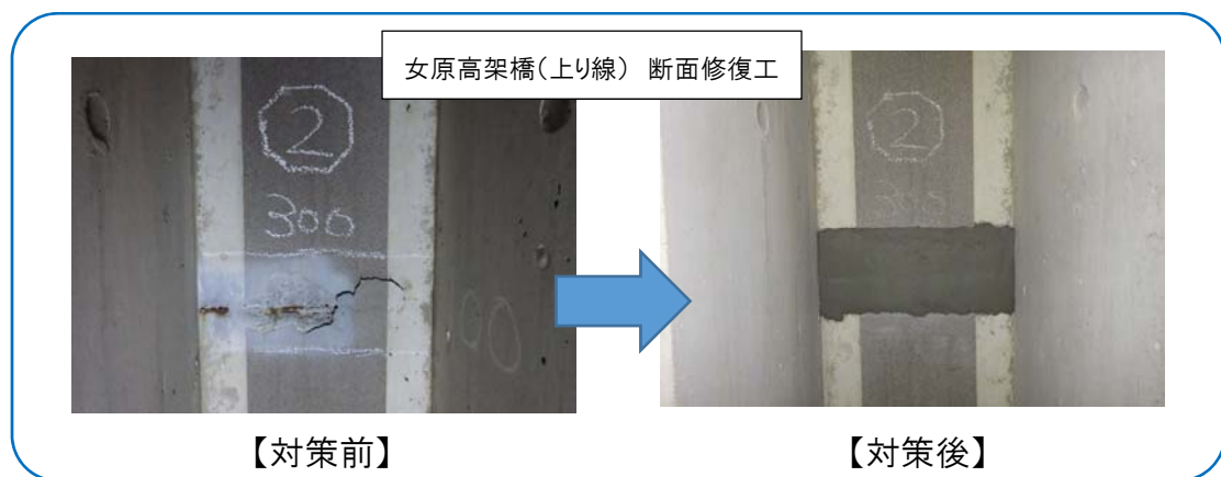
●図5 橋梁補修状況写真
